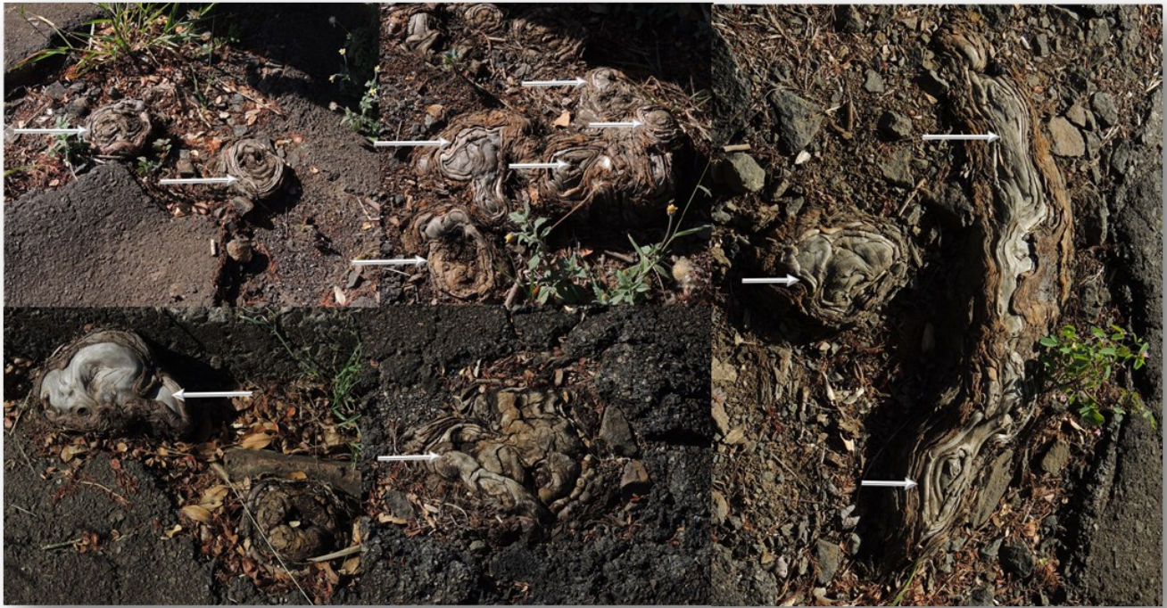
Figura 48 — Detalhe dos pneumatóforos (setas) rompendo o asfalto
